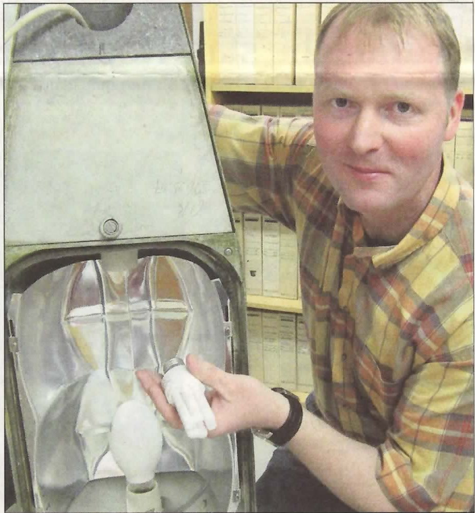
Stefan Müller demonstriert: Im Lampenkoffer werden HQL- gegen Energiesparlampen getauscht sowie die Vorschaltgeräte angepasst.
